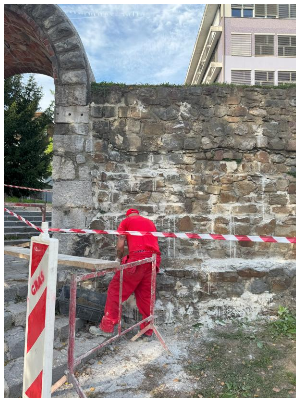
d) južna stran po injektiranju
