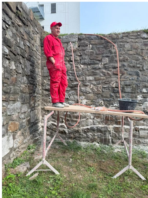
b) južna stran za časa injektiranja
