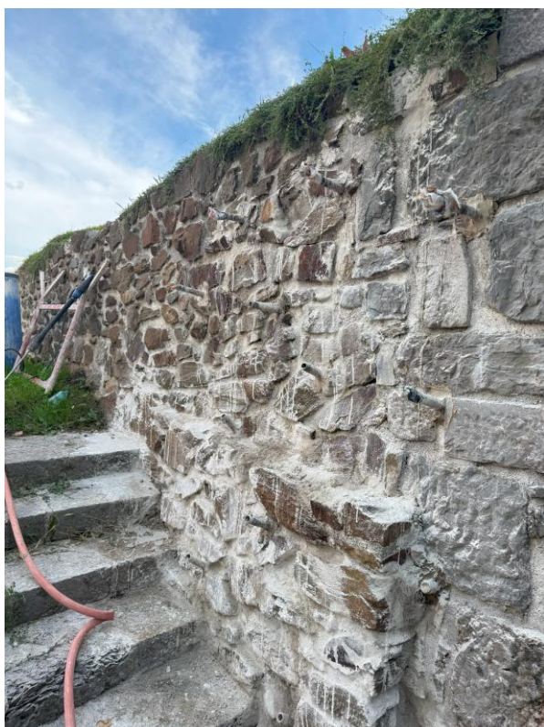
c) Severna stran po injektiranju
