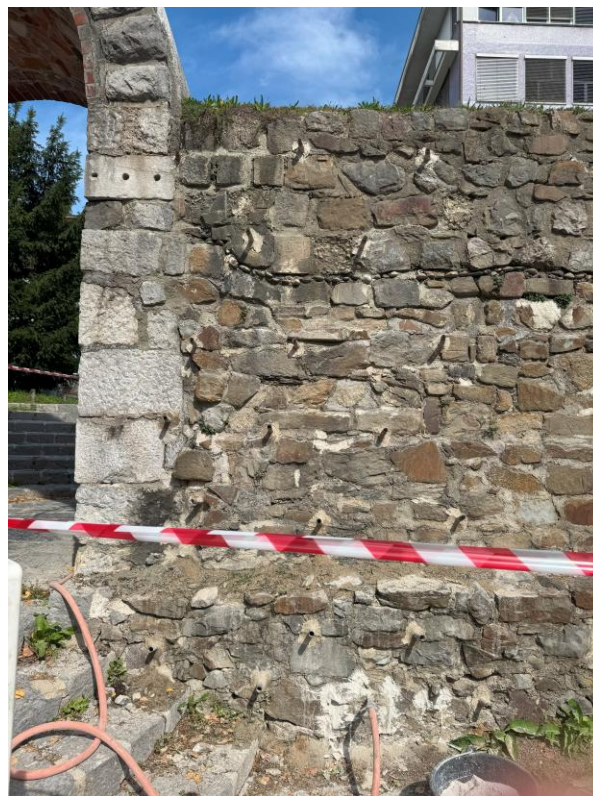
b) južna stran za časa injektiranja
