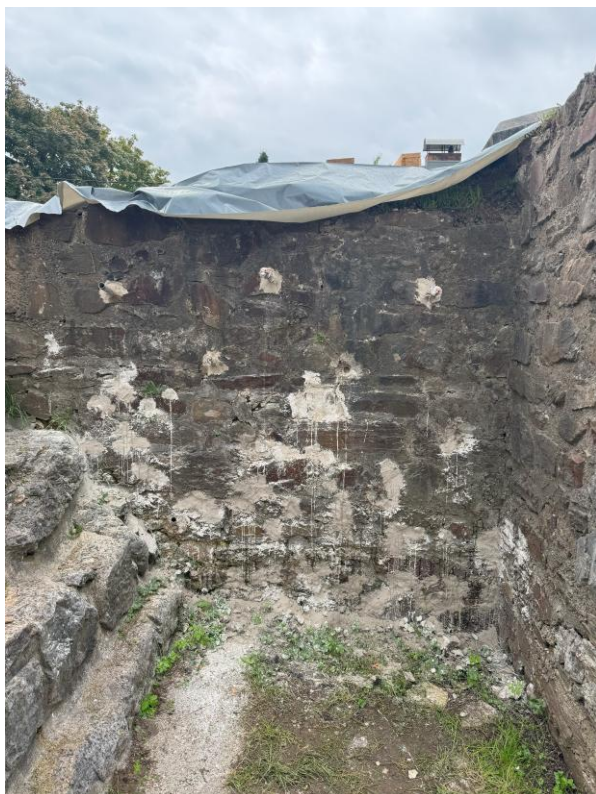
a) Severna stran za časa injektiranja
